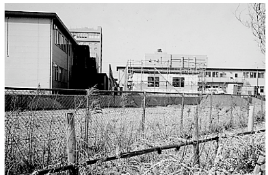
渚の大田寮は未だ工事中、果たしてどのような施設になるか？
